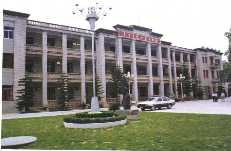
中共惠安县委办公大楼
