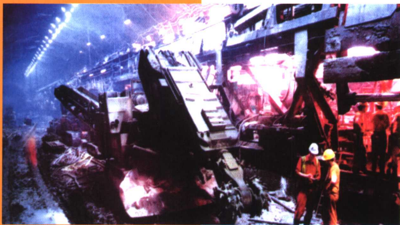
英吉利海峡海底隧道施工现场
