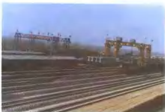
▲施工中的宁西铁路南阳段
