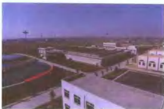
▲投入运行的市污水处理厂
