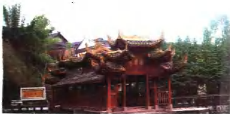
古朴精巧的永济桥(建于 1765 年)
