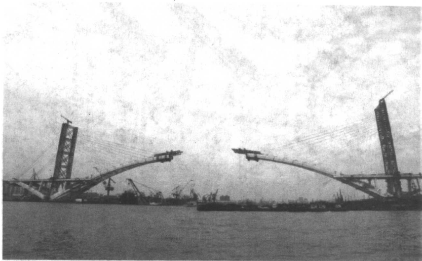
图 0.3 上海卢浦大桥钢管混凝土拱肋吊装
