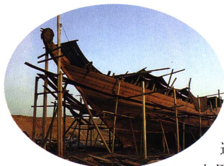
阿曼正在建造的一艘木板船
