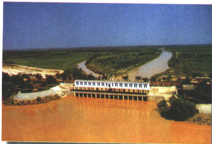
中牟县赵口引 黄灌渠渠首闸 (张进平 摄)
