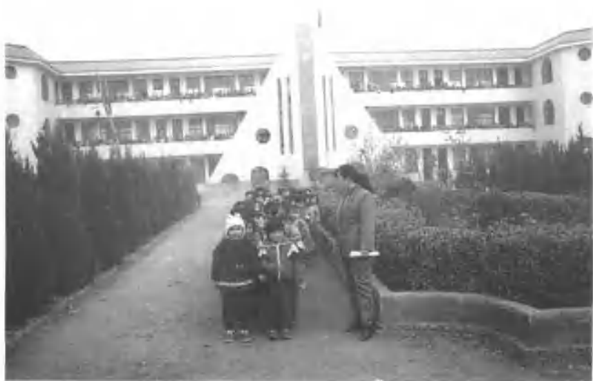
水屯乡中心小学（水屯）全貌
