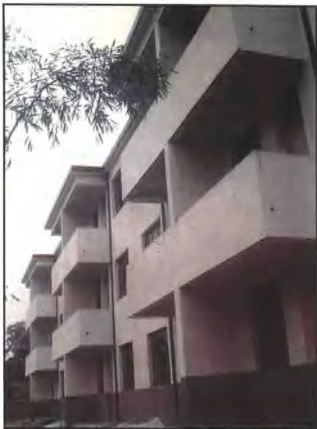
常兴乡初级中学新建的教师宿舍楼
