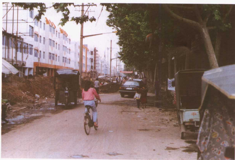
1995年市政府决定对迎 宾路拆扒改造，路北侧的土 地进行招标出让，收出让金 550万元，用于旧城改造。左 图为改造建设中的迎宾路
