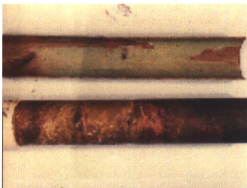
图5-5 凝汽器空冷区氨蚀 (见第162页)
