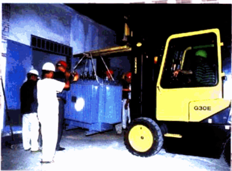
▲深夜到居民小区更换配电变压器的“零点抢修”
