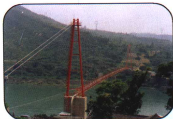
输油管线大型河流跨越
