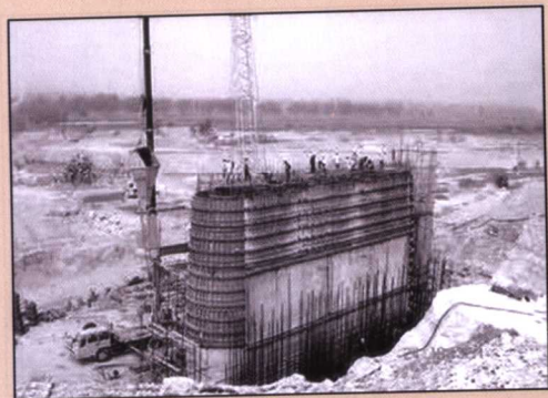
▲ 1978年2月，第五届全国人民代表大会第一次会议决定兴建将长江水引到黄河以北的南水北调工程。图为南水北调中线一期工程之一——河北漕河施工现场。
