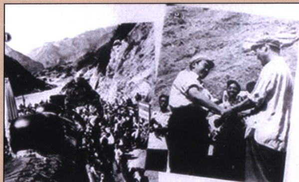
▲ 1957年7月，连接西南、西北全长658公里的宝成铁路建成通车。图为从南北两段开出的列车在接轨点会合。图为工程人员互相庆祝。
