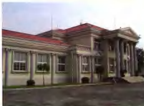
现代化的基层供电营业所
