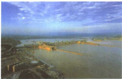
图 葛洲坝水利枢纽工程位于南津关东的长江上，有“长江第一坝”之称。
