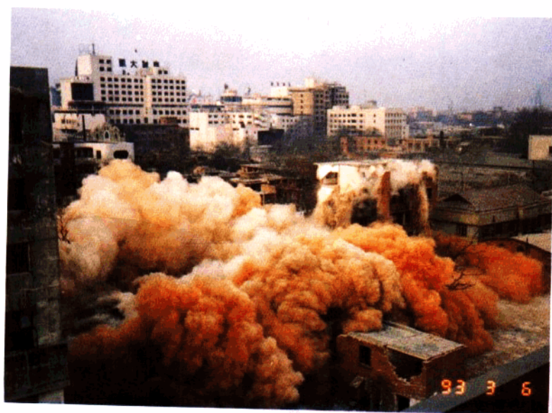
「华诚商贸中心」爆破现场
