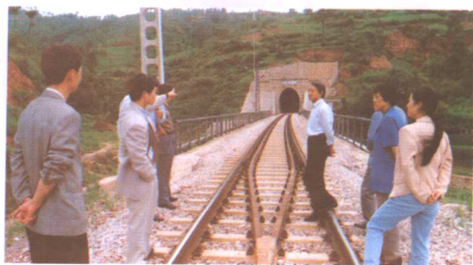
审计署驻昆明特派办审计组在南昆铁路现场
