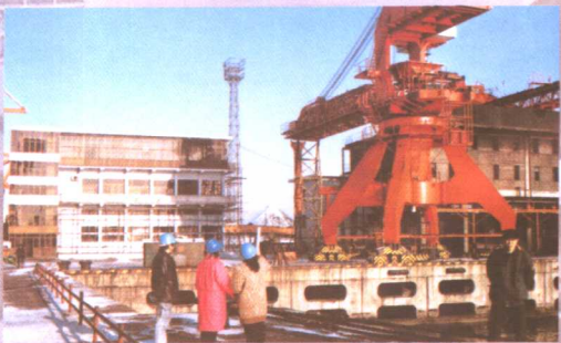
审计人员对秦皇岛港务局自筹资金2.4亿元技术改造项目进行现场勘察
