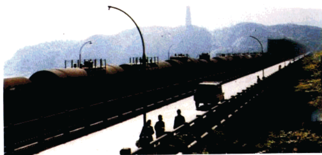
铁路、公路两用桥——黔城大桥。
