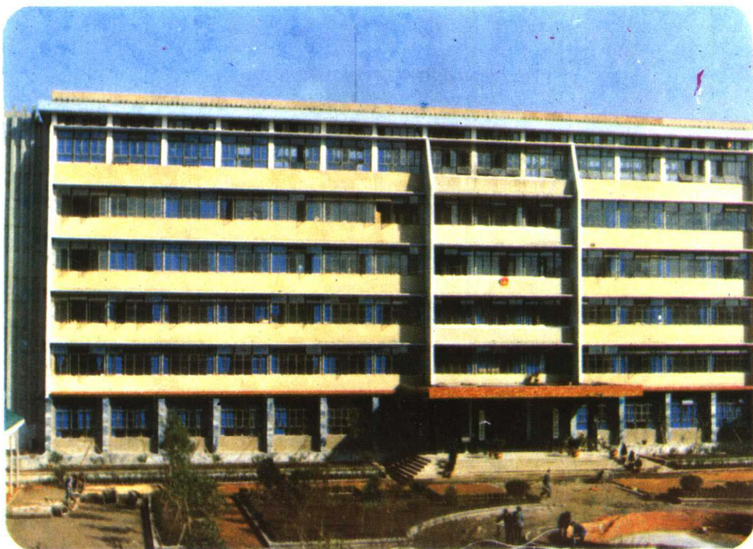
蒲江县人民政府办公大楼
