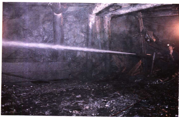
△邵武煤矿水力采煤工作面
