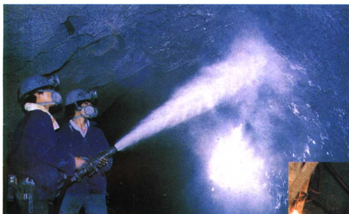
△锚喷支护工艺
