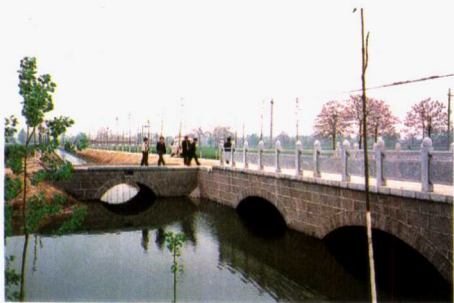
▽ 农开工程连体桥
