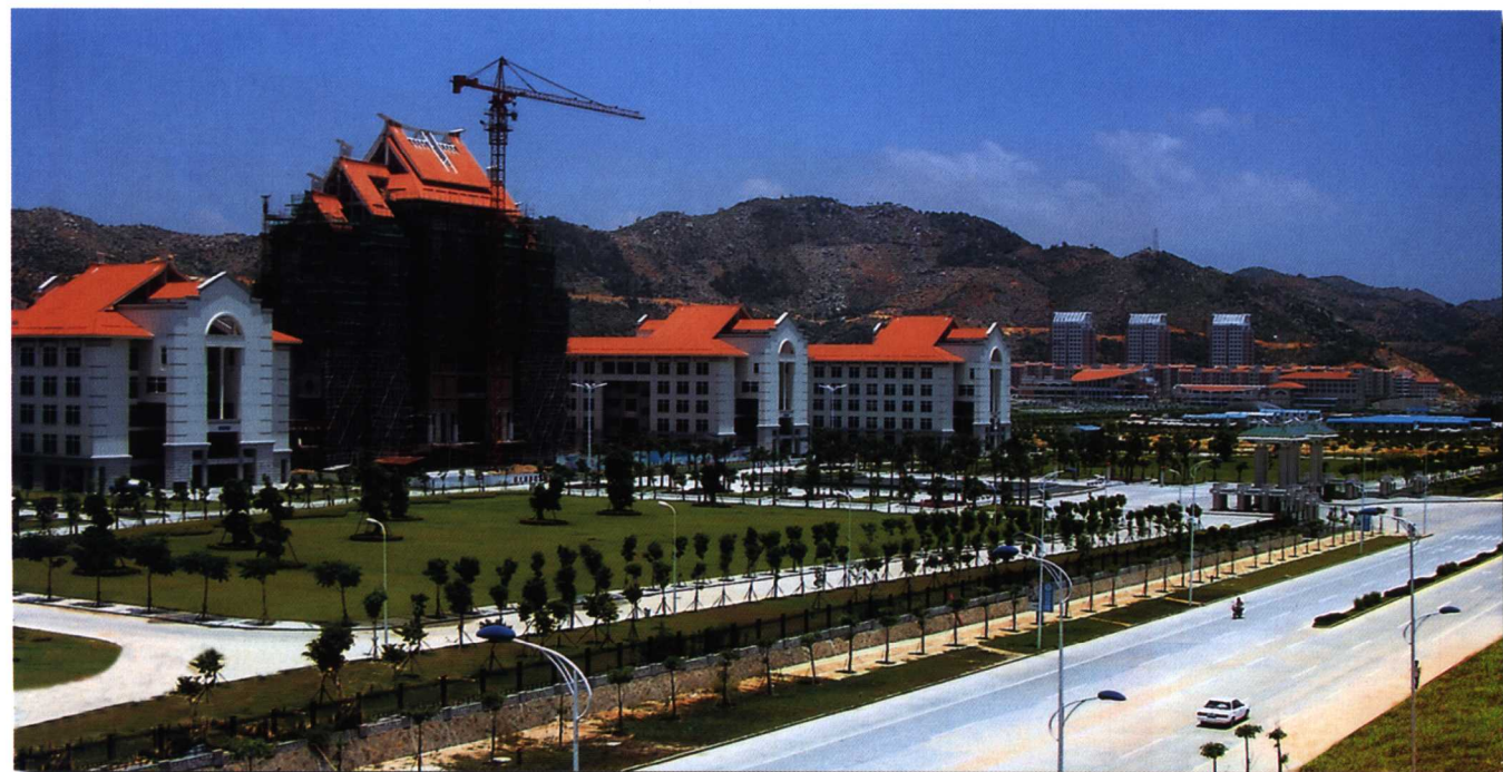
厦门大学漳州校区二期工程投入 2 亿元,整个施工工程进入尾声。
