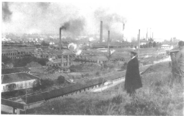
汉阳铁厂，前临汉江，后靠龟山。清末湖广总督张之洞创办，1893 年建成投产，有大小十个分厂，是当时亚洲第一大钢铁联合企业。图为 1894 年 7 月 3 日张之洞视察汉阳铁厂
