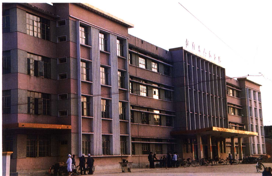
县医院门诊楼
