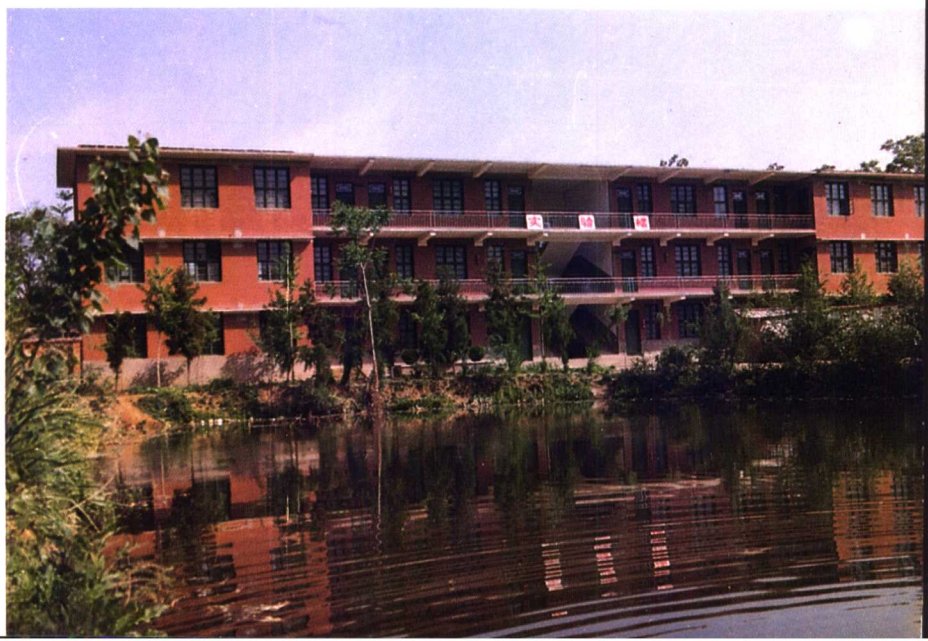
县高中实验楼
