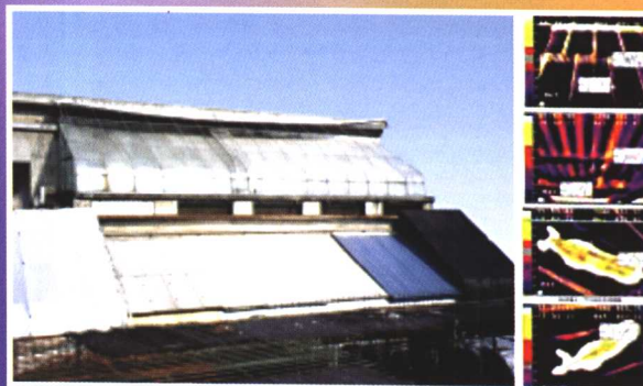
以红外热图像分析和猪的生理参数无线遥测先进仪器解决南方石棉瓦屋顶猪舍夏季降温、冬季保温的实际问题
