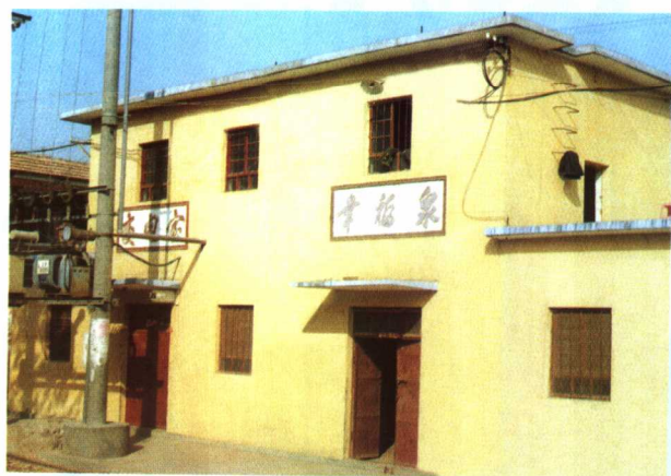
机井（幸福泉）与变电室
