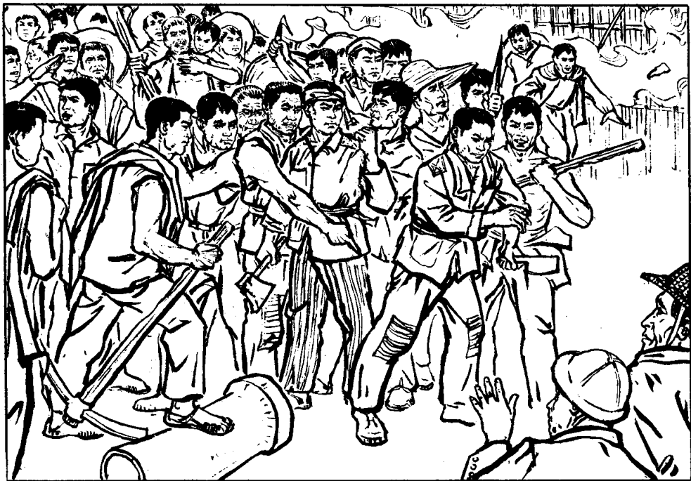
( 5 ) 旧社会, 建筑工人遭受层层剥削和压迫, 生产安全谈不上。 一顶普通的安全帽, 只有资本家、工头才能戴。
