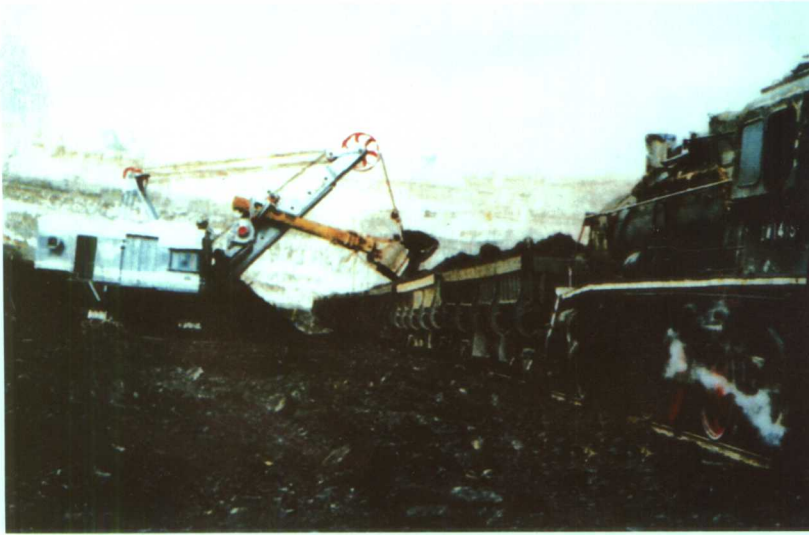
采煤现场一角
