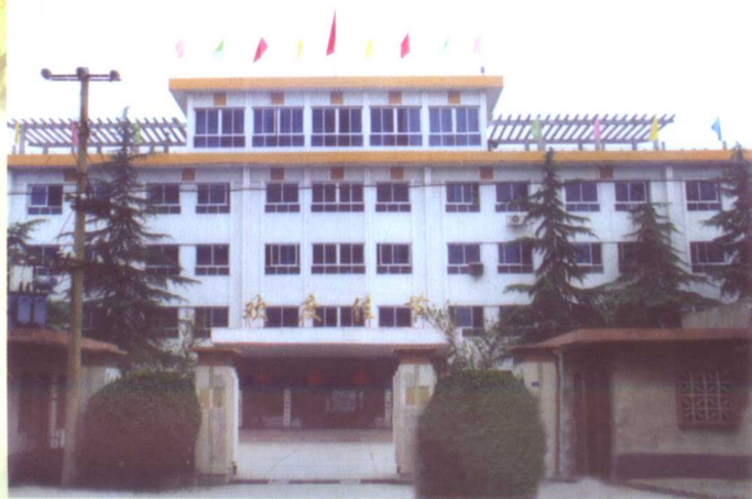
南阳市烟草专卖局办公大楼
