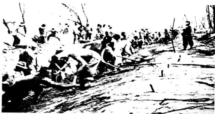
互助组的农民在挖排水沟
