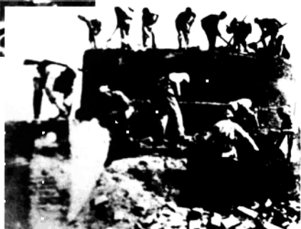
民兵、群众在拆除日军炮楼
