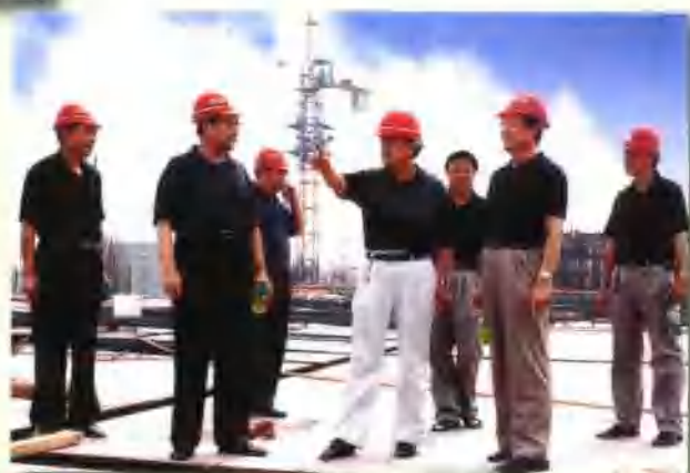
副市长魏有元（前右二）深入濮阳职业技术学院新址建设工地检查工作
