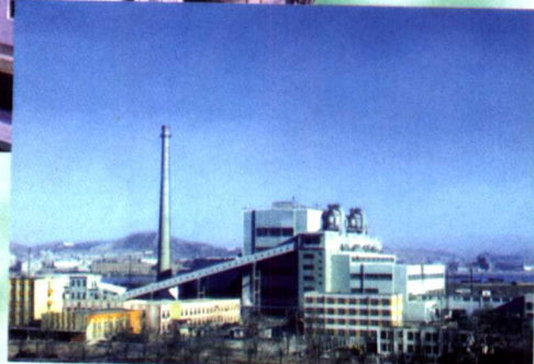
公司承建的大连北海头热电厂
