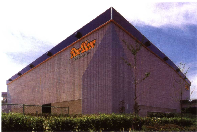
【使用材料及部位】 竖向挂装的条形外墙板 【建筑物名称】 室内练习场
