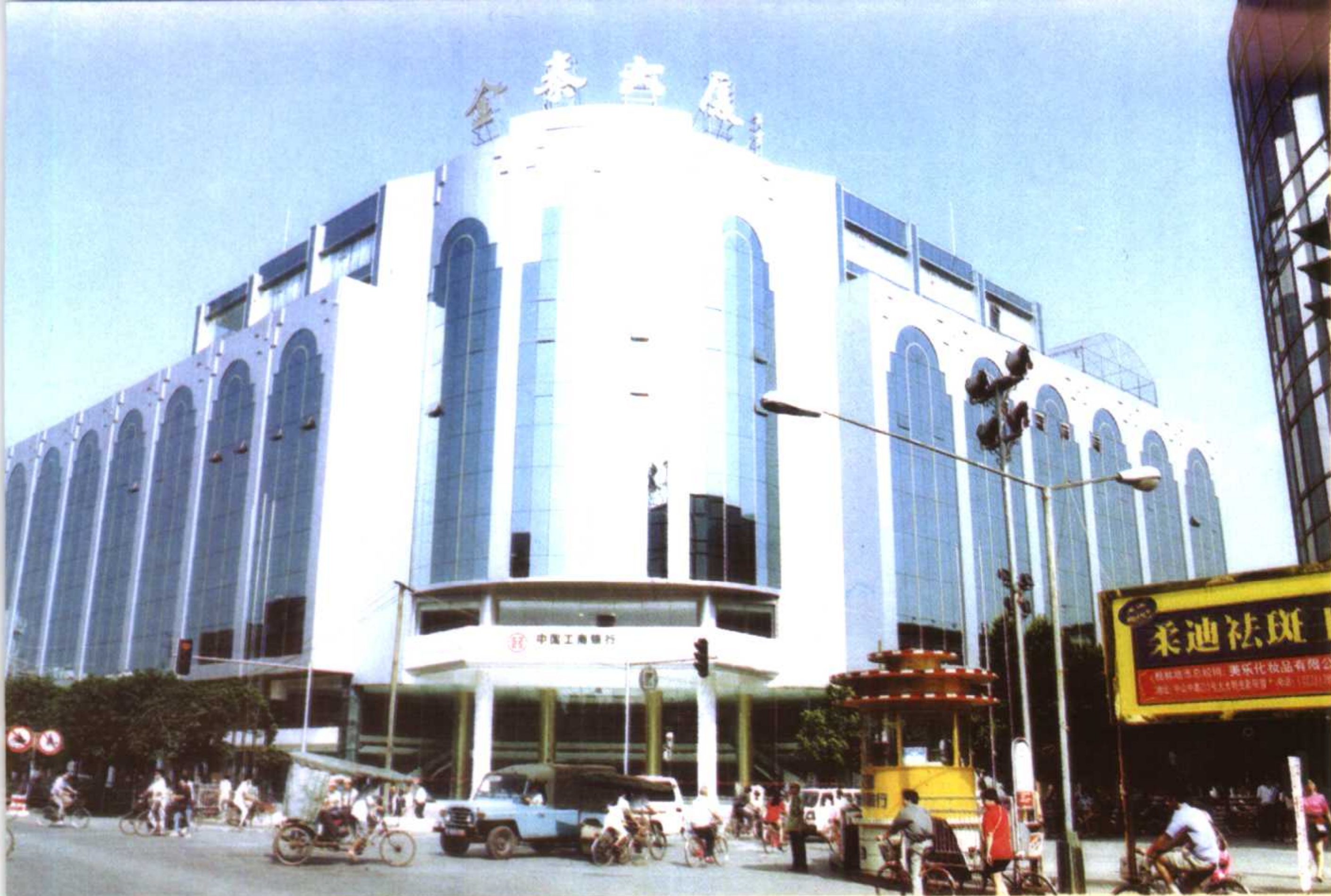
中国工商银行桂林分行办公大楼
