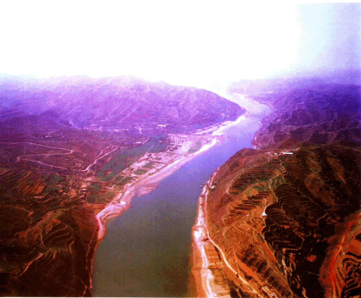
黄河小浪底水利枢纽工程坝址
