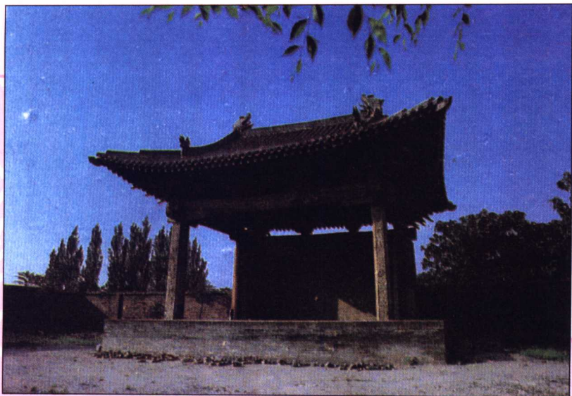
▲ 在山西臨汾魏村的元代戲台，是我國現存最早的磚木結構戲劇舞台
