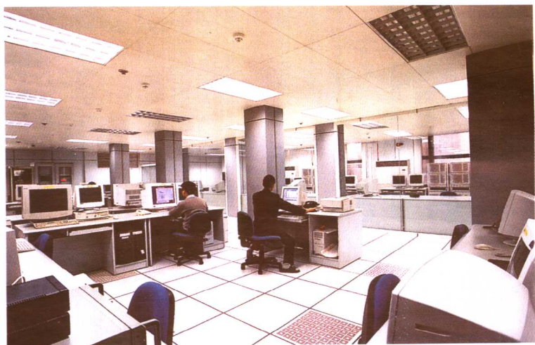
河南电网调度自动化监控系统
