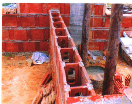
图 4-19 装配式轻型砖的施工情况 (承张福贵教授惠赠) a) 外部状况, b) 内部状况
