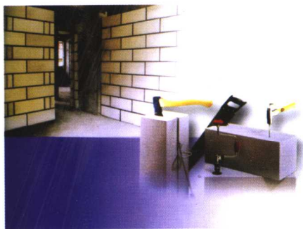
图 5-2 用 ALC 砌块砌筑的隔墙
