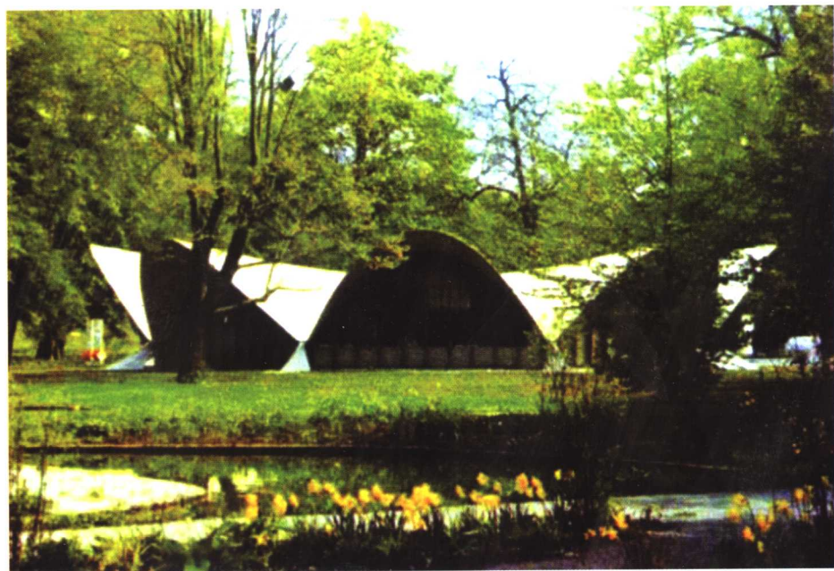
图 8-2 在德国 Stuttgart 用 GFRC 建造的筒壳建筑 (承 BFF Concrete Plant+Precast Technology 惠赠)
