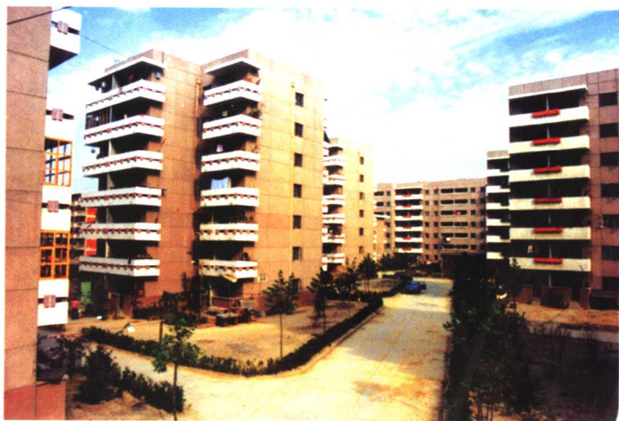
图 4-5 用抗震砖砌筑的 7 层住宅
