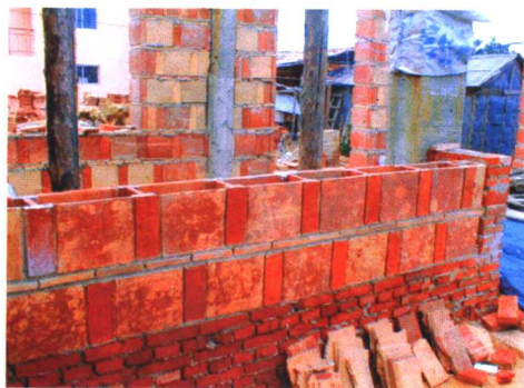
图 4-19 装配式轻型砖的施工情况 (承张福贵教授惠赠) a) 外部状况, b) 内部状况
