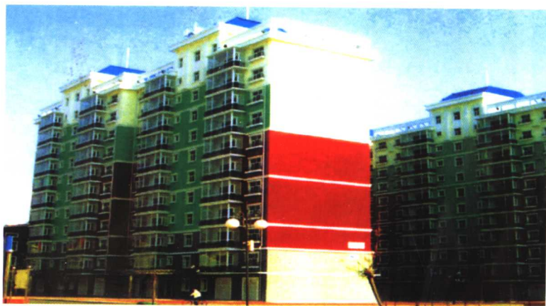
图 7-2 大庆世纪家园小区两栋 11 层配筋砌体结构住宅 (承王金国高工惠赠)
