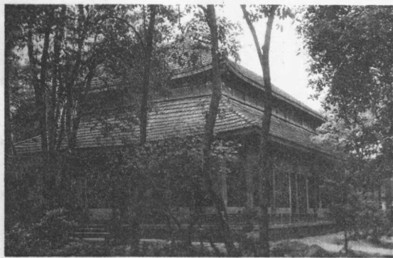
19. 维修前的跳舞厅
