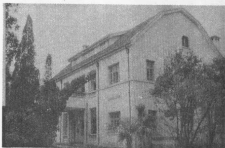
18. 维修前的四号楼
