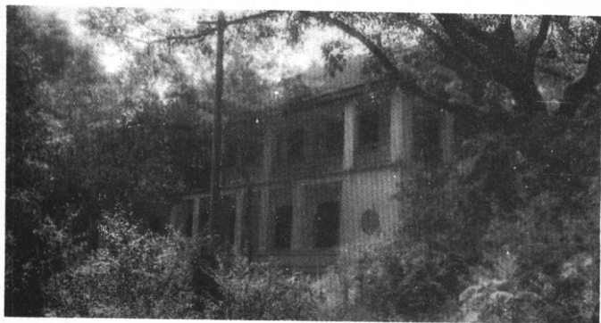
25. 维修前的 三号楼
