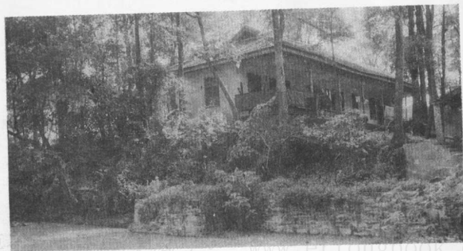
23. 修复前的钓鱼台
