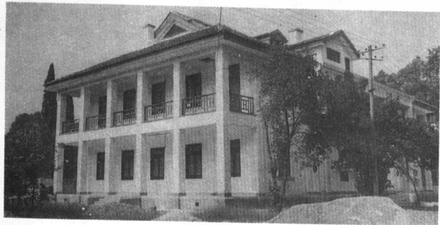
24. 维修中的二号楼
