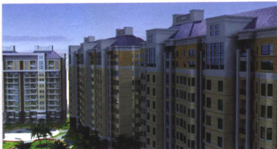
会所一侧的 A 区主体建筑
