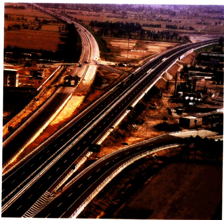
安(阳)新(乡)高速公路
