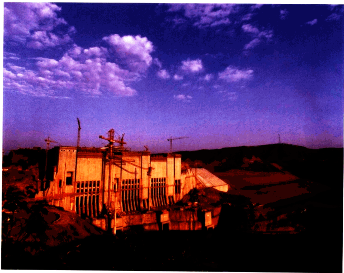
建设中的黄河小浪底水利枢纽工程
