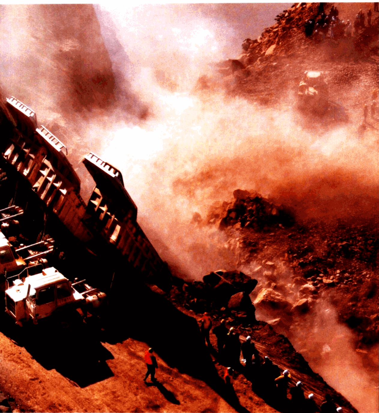
国家重点工程——黄河小浪底水利枢纽工程大坝1997年10月28日截流成功
