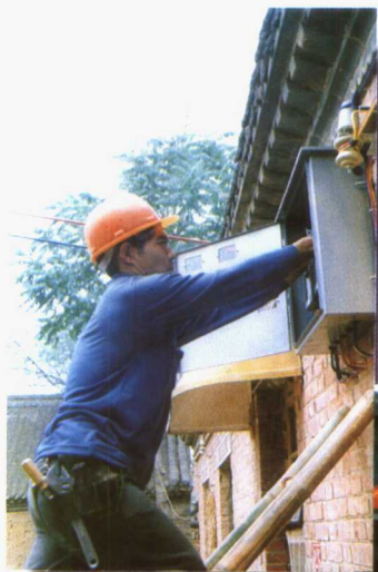
千余名施工人员不怕困难 奋战在农网改造一线
