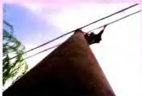
爬杆检修线路
