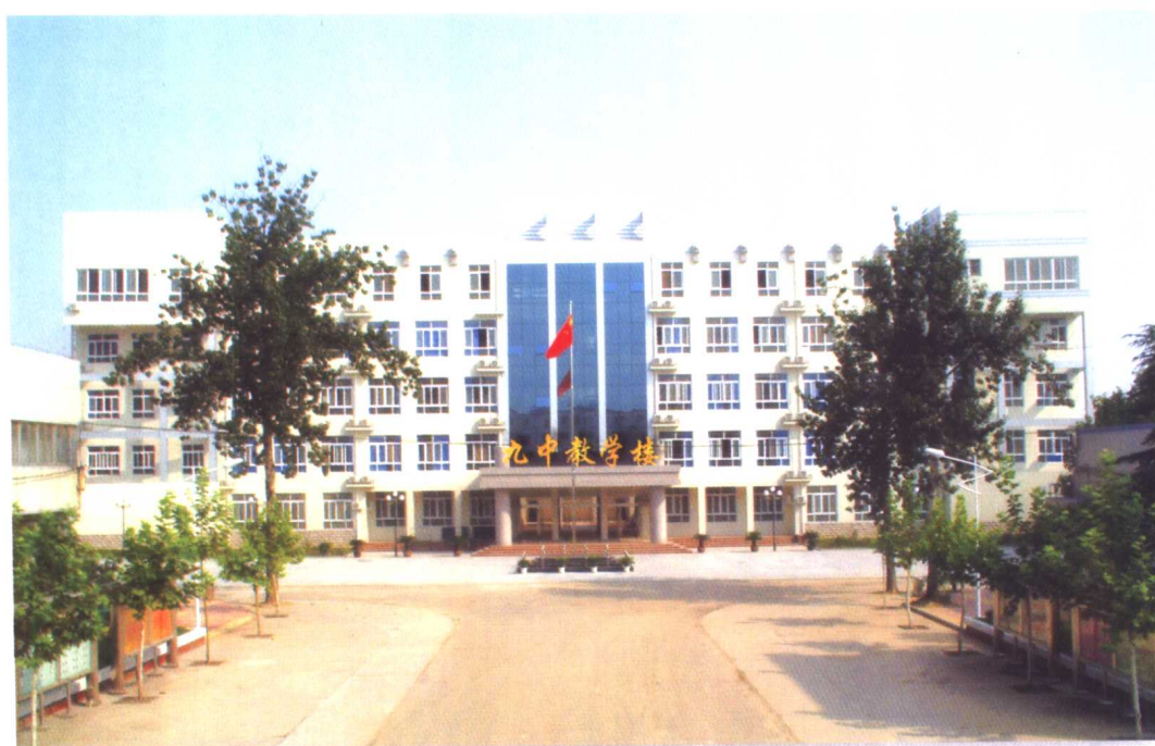
2003年8月落成的新教学大楼
