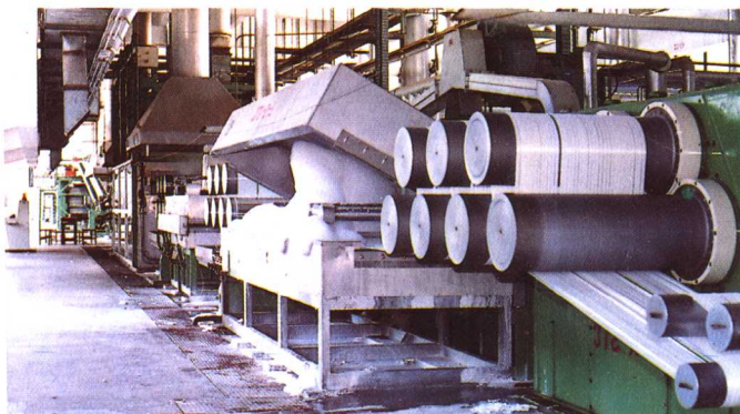
厦门利恒涤纶有限公司短纤生产线
