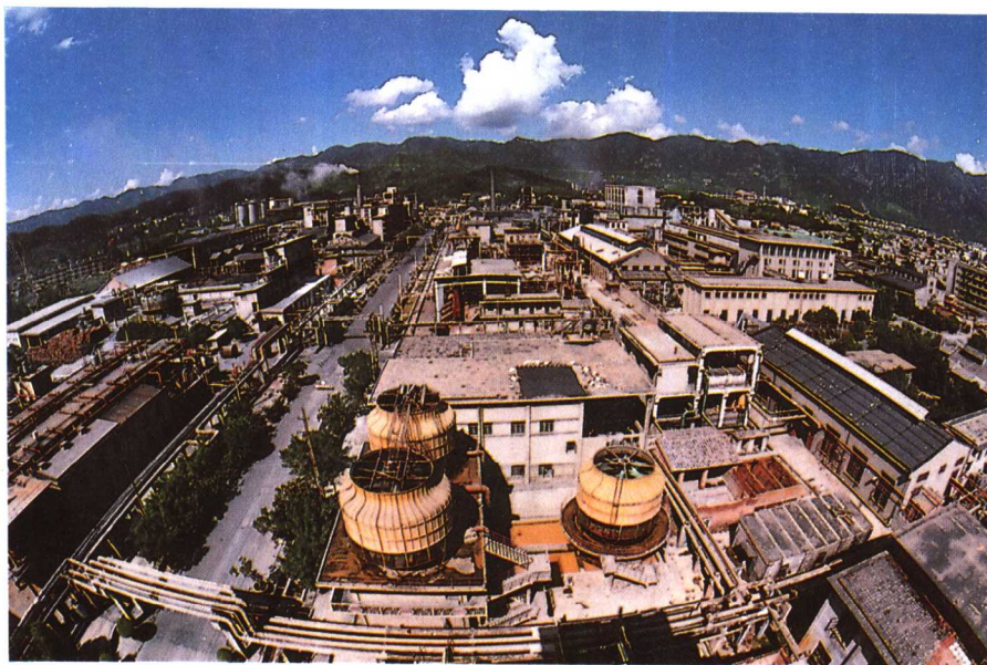
福州第二化工厂厂区俯瞰
