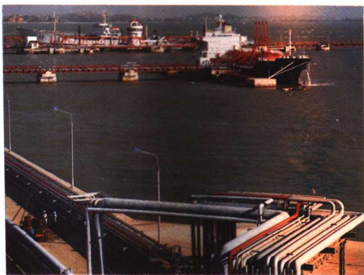
福建炼油厂 10 万吨级油码头
