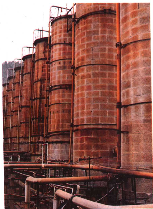
邵武化肥厂硝酸车间一角
