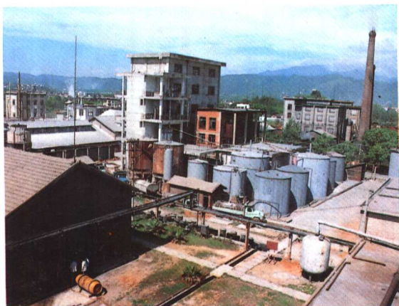
龙岩化工厂厂区一角
