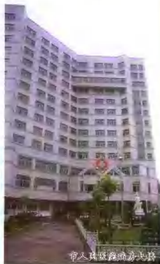
市人民医院病房大楼
