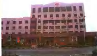
市卫生局办公楼
