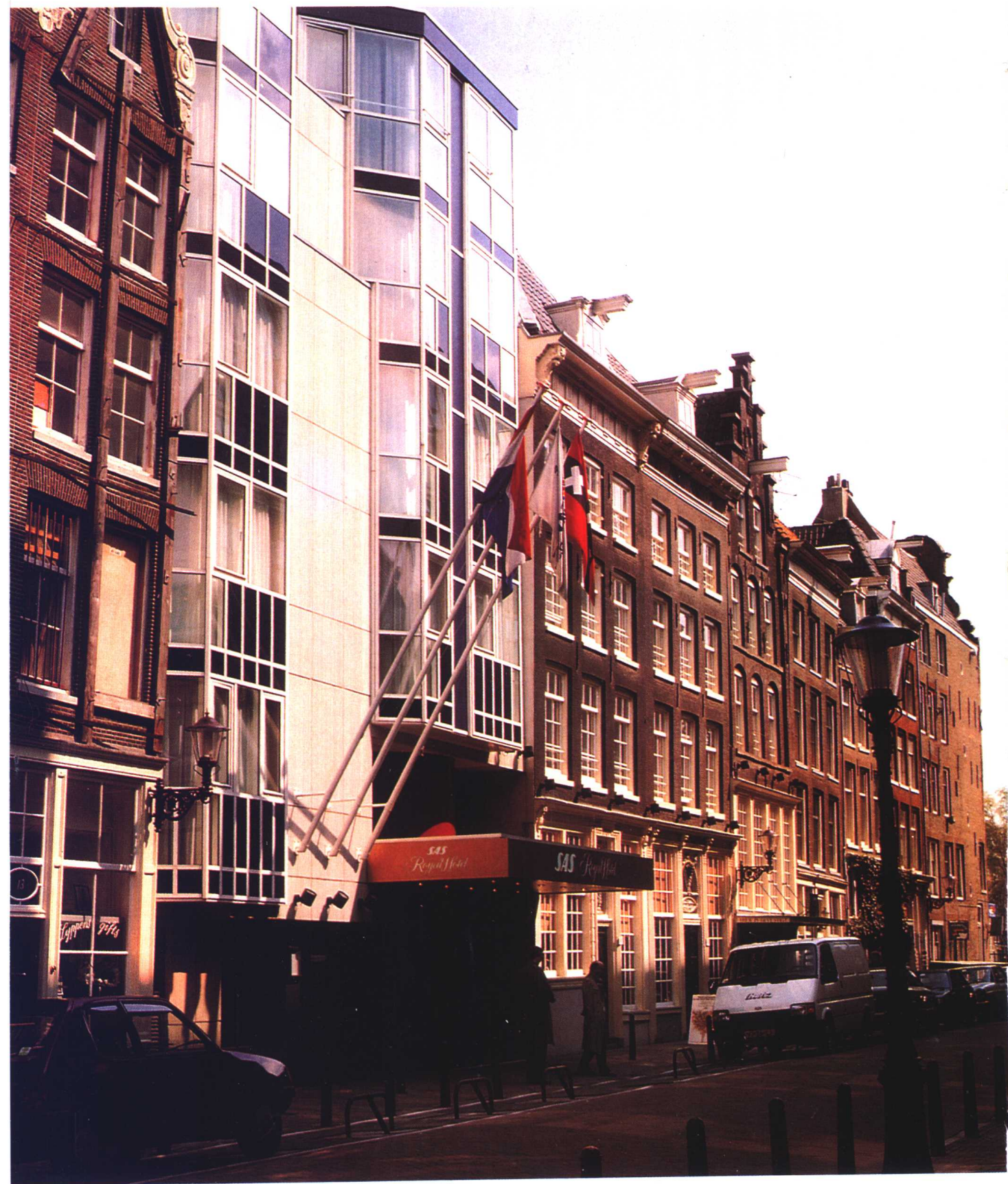
铝合金玻璃窗与传统的欧式建筑有机结合， 组成主立面，斜插彩旗，引人注目。
