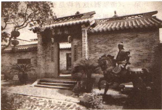
东莞水南袁崇焕故居(复建)
