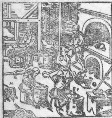
圖6 阿格利柯拉書中的圖畫：銀的加工。
