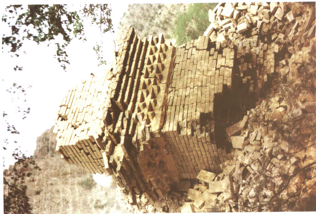
1. 方塔残存西北角塔檐 (西北—东南)
