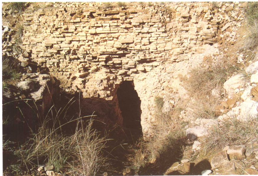
1. 方塔底层正面塔壁的“门状”盗洞（南—北）
